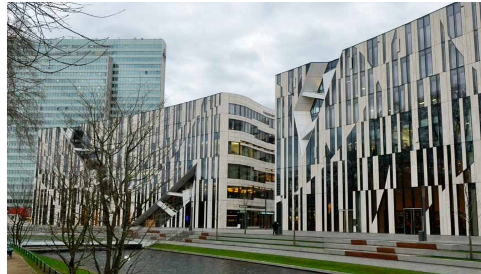
Architektonisches Schmuckstück Kö-Bogen, Düsseldorf. Noch fehlt das Grün in den Einschnitten in der Fassade. (Bild: Omnium Technic)
